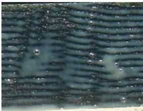
塗布をしたボンド表面に小さな気泡が浮いてきた時が接着タイミングです。気温などによりオープンタイムに差がありますので、現場での確認をお願いします。C-3 シリーズは透水性が良いので乾燥時期などはマットにボンドが吸われますので、早めの接着が良施工のコツです。
