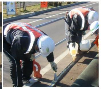
塗布工を追いかけるようにスクレーパーなどで伸ばして行きます。平地の直線な場所の施工で、非常に効率の良い方法です。
